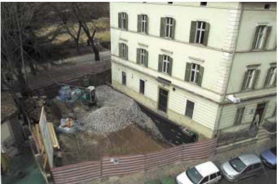
Das Stiftungsgebäude an der Talfergasse mit Baustelle
