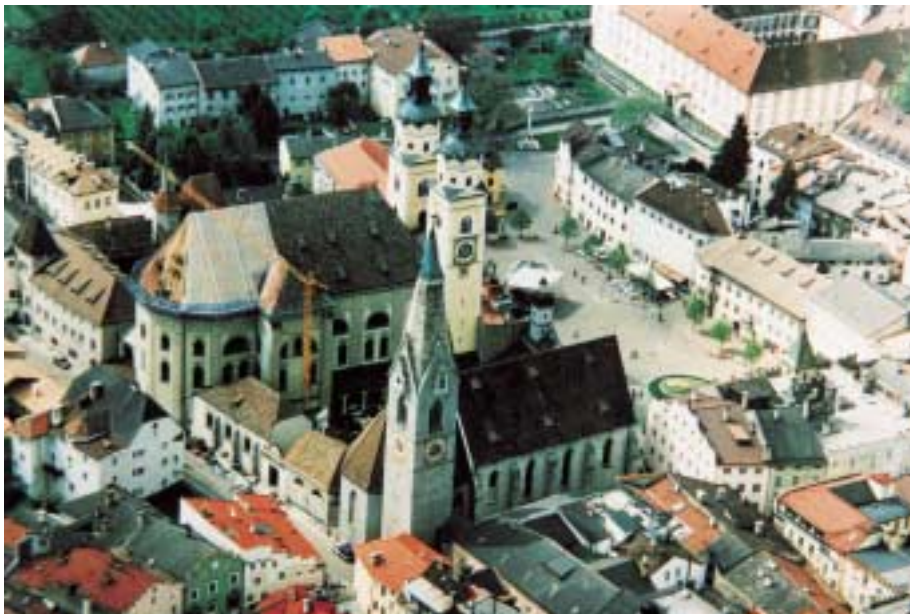
Vor dem Abschluss: Die Sanierungsarbeiten am Dom zu Brixen
