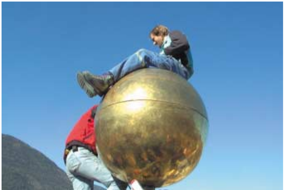
Arbeit in luftiger Höhe
