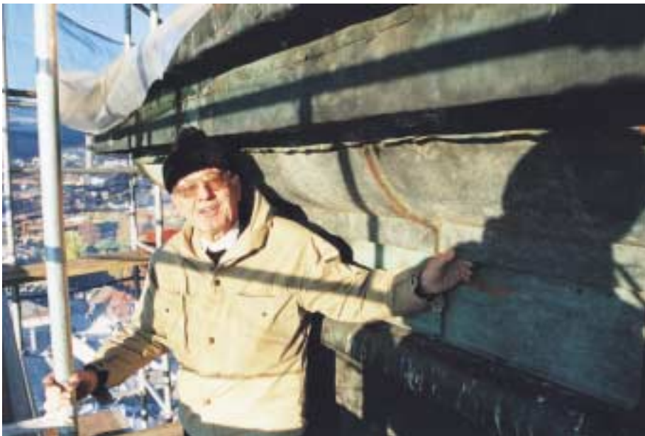
Domdekan Johannes Messner führt durch die Sanierungsarbeiten
