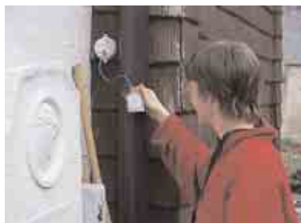
Sensoren an der Kirchenwand messen die Temperatur des Mauerwerks
