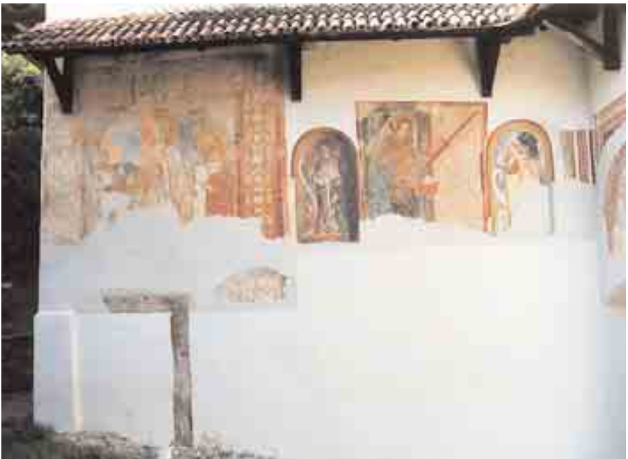
Nach der Restaurierung
